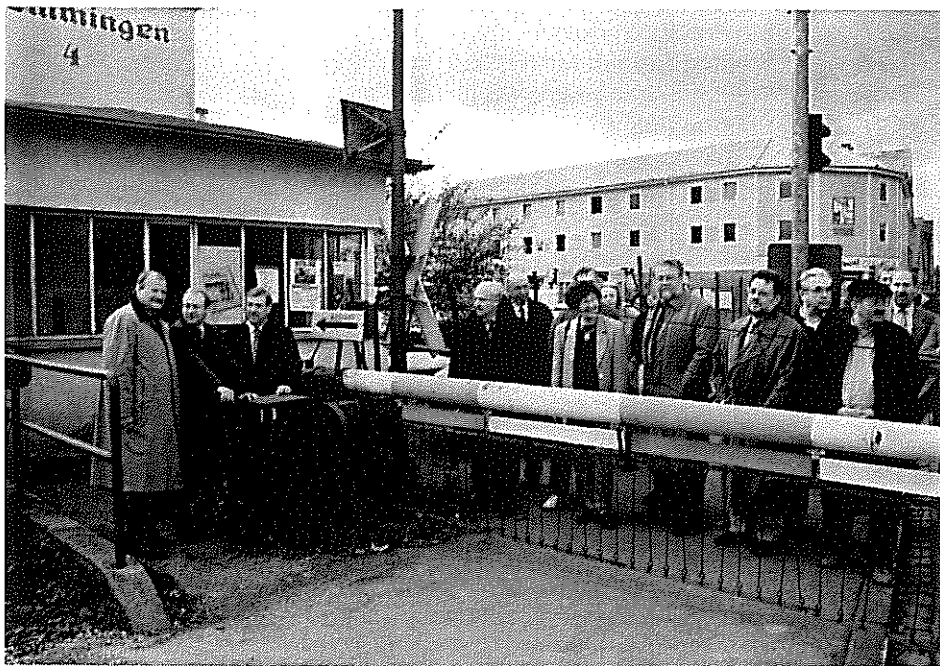
Nach 135 Jahren wurde der Bahnübergang an der Augsburger Straße geschlossen. Letztmals wurden die Schranken am 7. November 1997 um 12:00 Uhr heruntergelassen. Dies war zugleich der Baubeginn für die Bahnunterführung.
