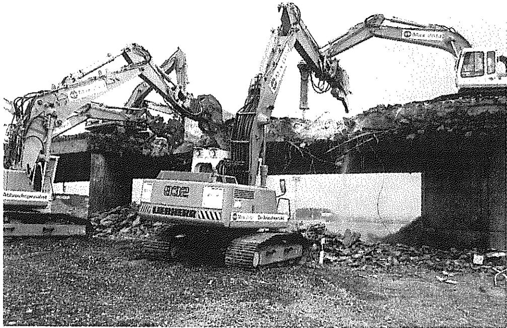
Mit unglaublicher Kraft zerbrechen Spezialfahrzeuge mit ihren Werkzeugen den Beton der Autobahnbrücke, die bisher über die A 96 führte. Das Brückenbauwerk mußte der neuen Autobahnauffahrt „Memminger Nord“ weichen.
