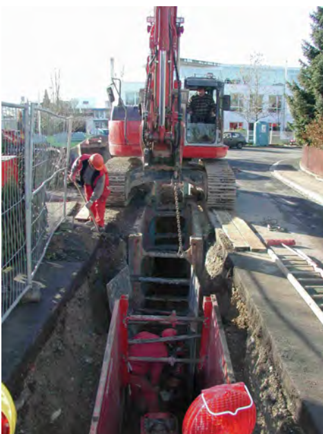
Gotenstraße: Kanalreparatur in offener Bauweise
