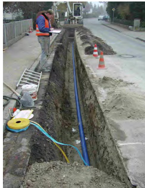
Ein langer Straßenaufbruch – hier die Obere Straße. Verlegt wurde eine neue Gas- und Wasserleitung.
