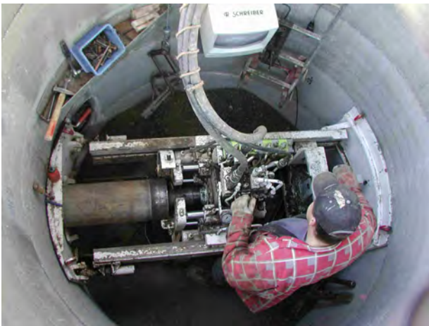
Kornstraße: Blick in die Pressgrube beim Rohrvortrieb
