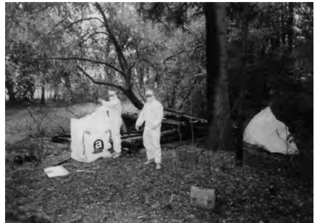
Bauhofmitarbeiter bei fachgerechter Asbestentsorgung Im Hintergrund abgebrannte Hütte aus Holz und Asbestzementplatten
