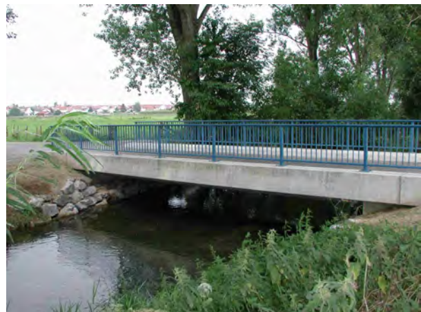
Neue Brücke im Zuge der Bettelgasse über die Memminger Ach in Steinheim
