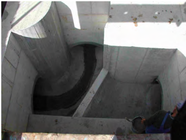
Anschlussbauwerk am Ebertring vor Einbau der Deckenplatte, rechts der alte Ablauf Richtung Norden.
