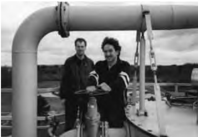
Arbeitssicherheit in luftiger Höhe am Gruppenklärwerk Stefan Anwander und Rainer Luibrand (v. rechts)
